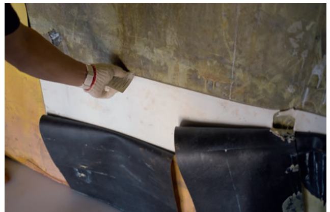
Controle van een achteraf aangebracht afdichtingsmembraan
